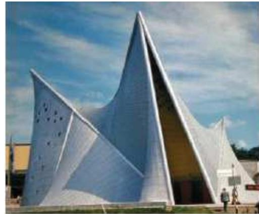
Pavillon Philips de Yannis Xenakis et Le Corbusier, ouvrage réalisé à partir de parabolöides hyperboliques.
